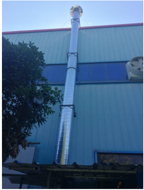
附图 3-2 生产废气排气筒
